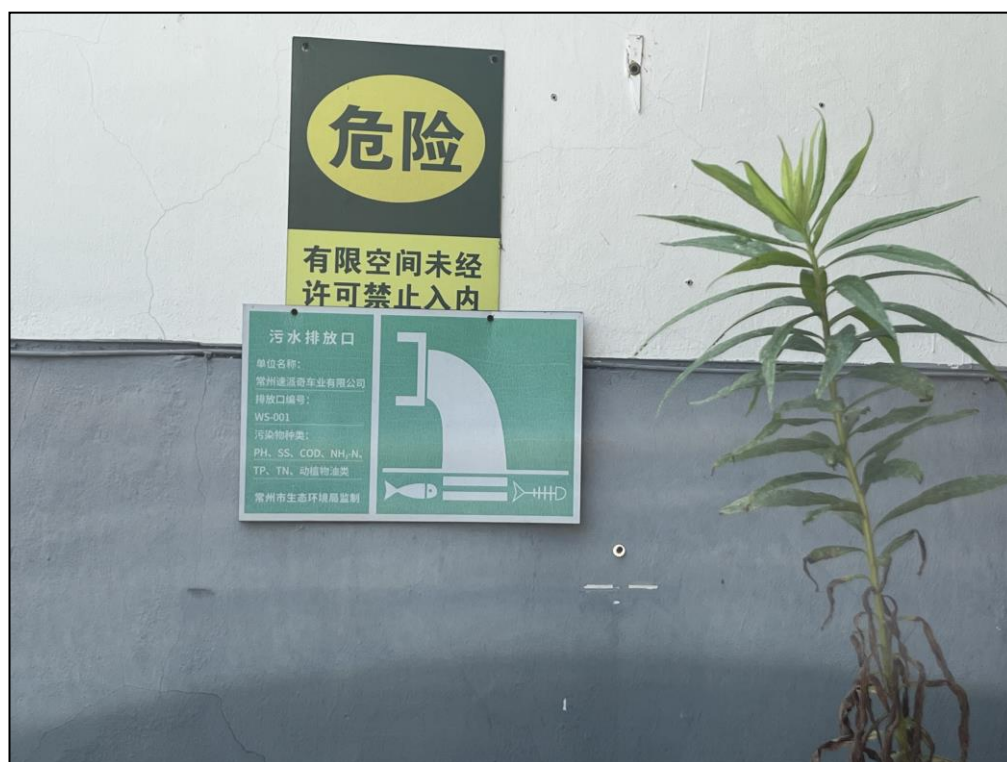
厂区西南角处污水排放口及环保标识牌
